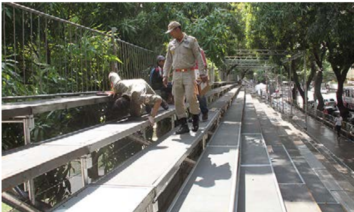
FIGURA 9: VISTORIA DAS ARQUIBANCADAS.
