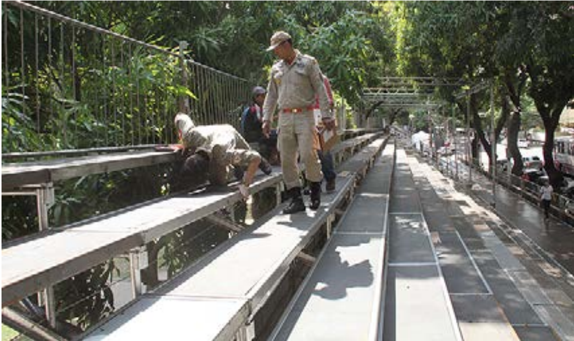
FIGURA 9: VISTORIA DAS ARQUIBANCADAS.
